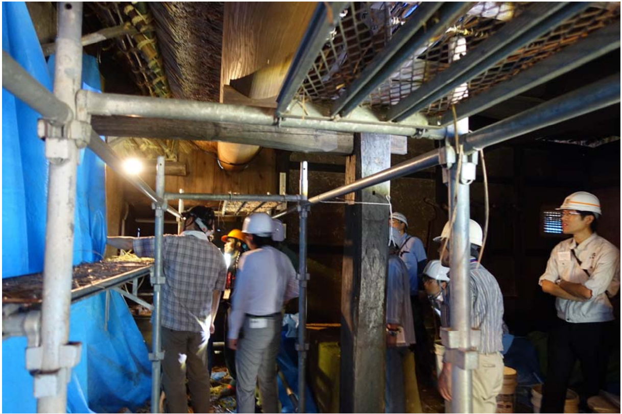
望月家住宅保存修理工事 5
