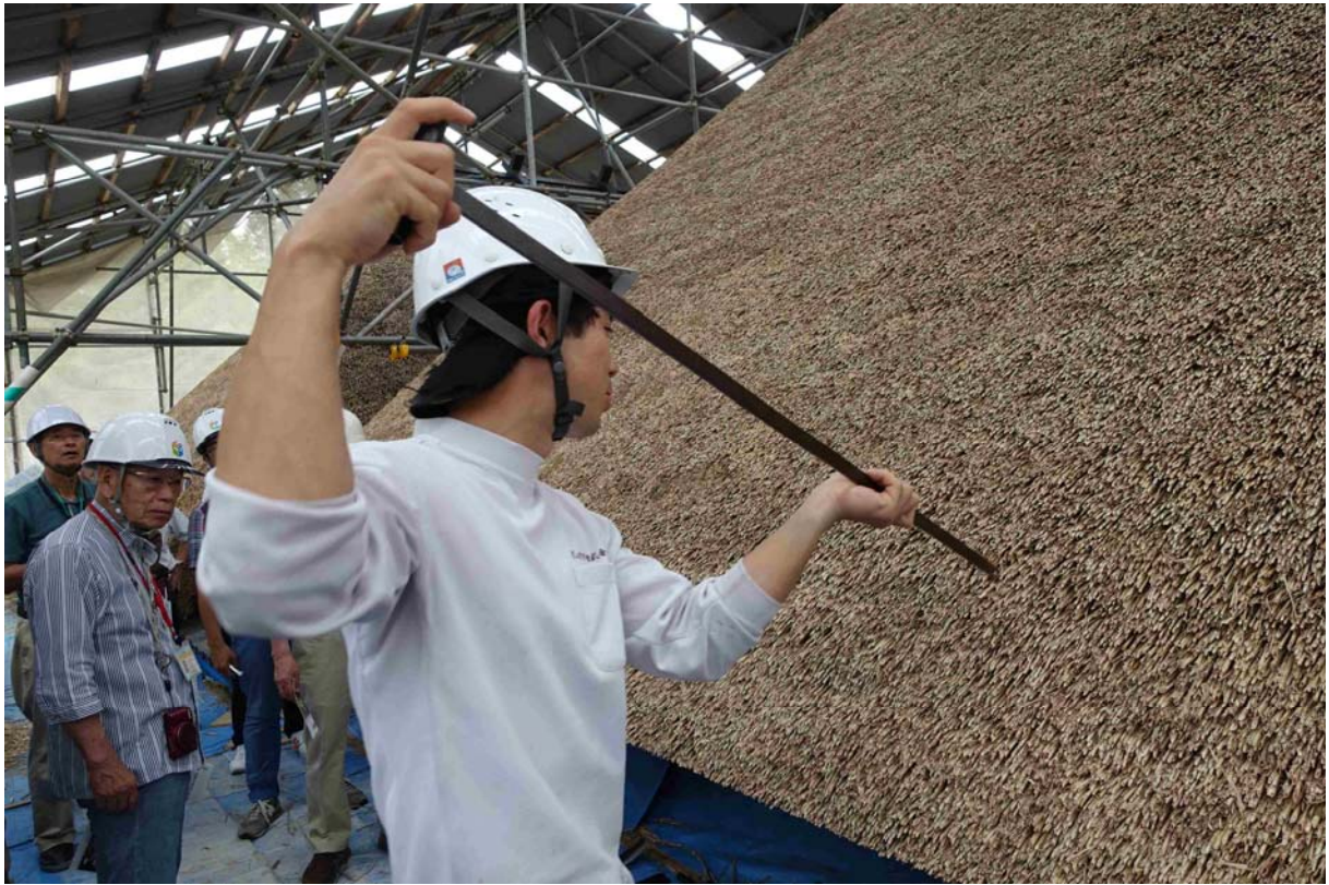
望月家住宅保存修理工事 3
