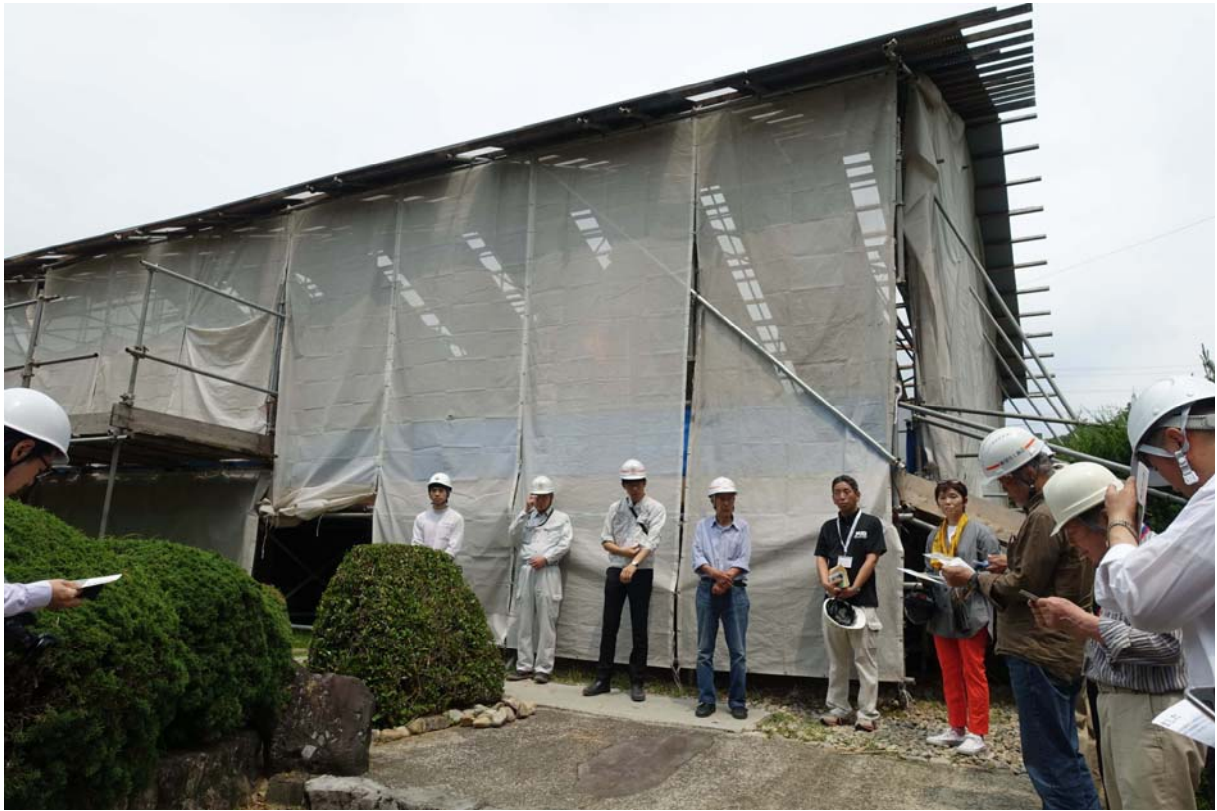
望月家住宅保存修理工事 1
