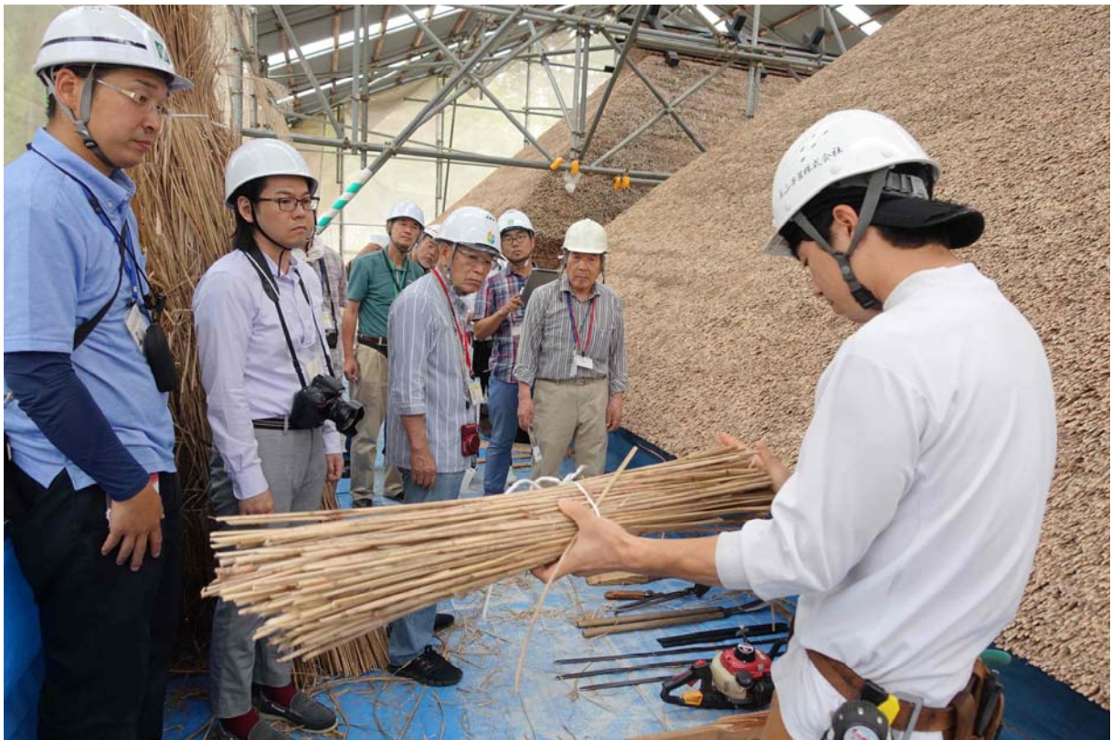
望月家住宅保存修理工事 2
