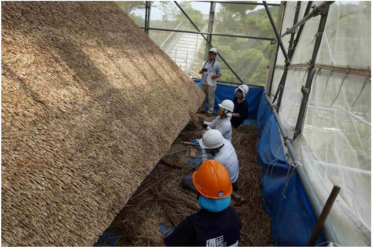
望月家住宅保存修理工事 7
