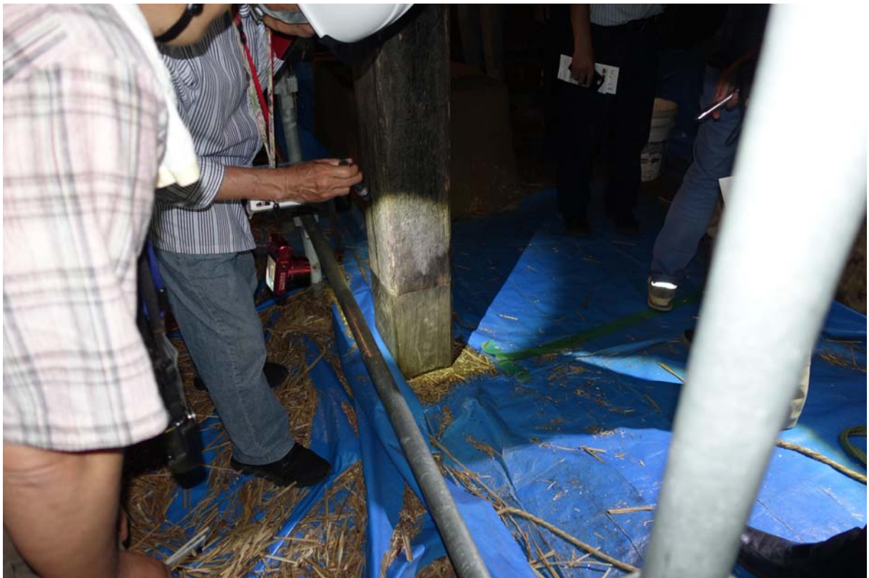
望月家住宅保存修理工事 6
