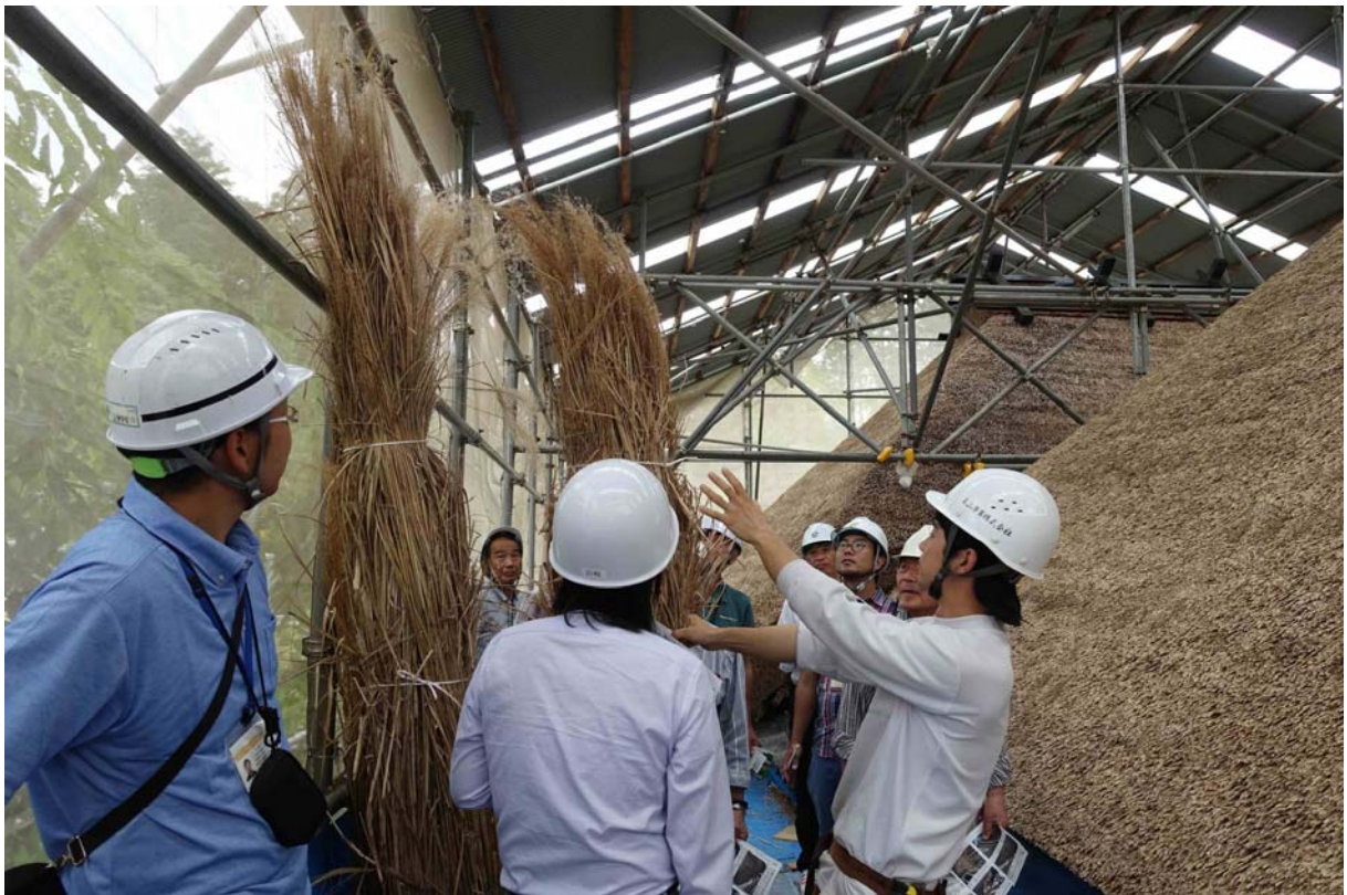
望月家住宅保存修理工事 4
